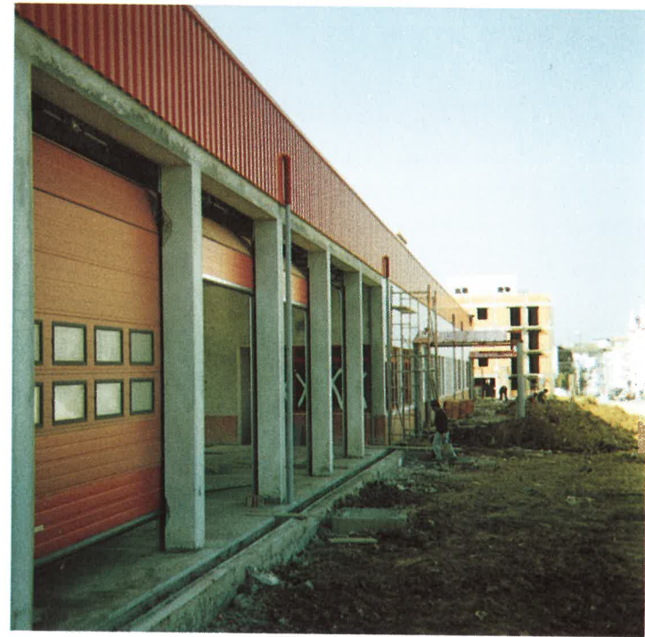
O novo quartel em construção
